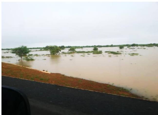
La piste sert de digue de protection contre les inondations
